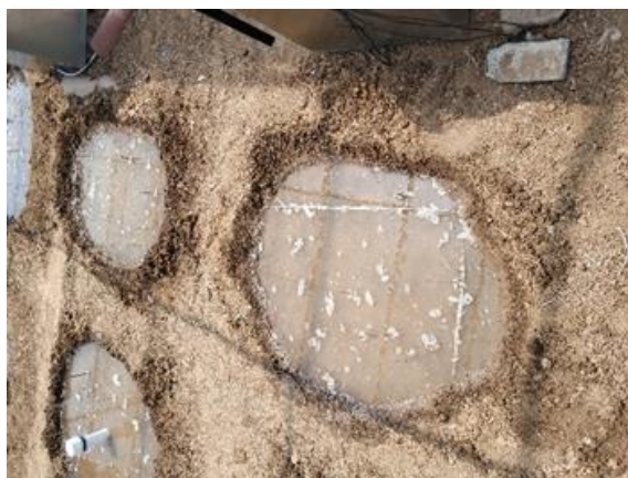
图 6 现场浇水实拍图
